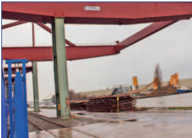
L'assemblage final aura lieu à Wondelgem (15 km d'Eeklo), où la travée pourra commencer son voyage sur l'eau jusqu'à Rouen.
