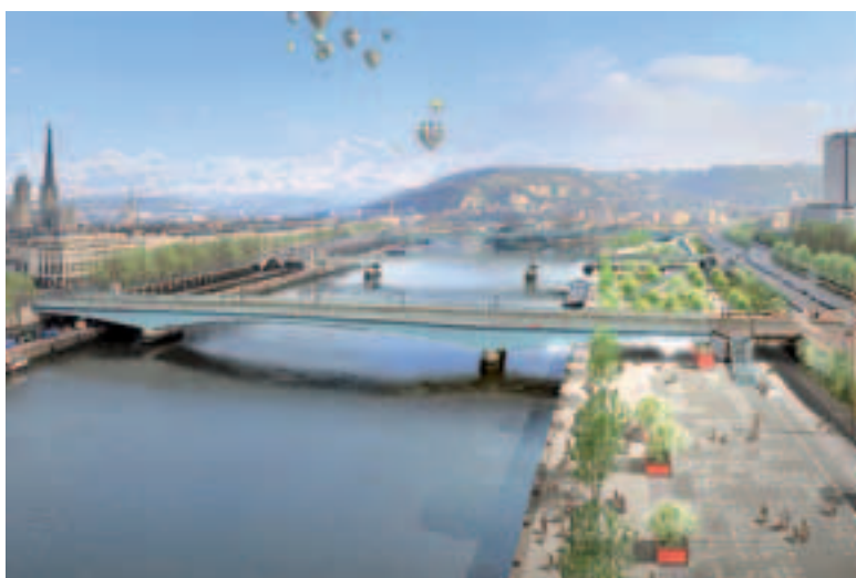
La première phase de travaux des quais bas rive gauche devrait s'achever d'ici à cet été.
