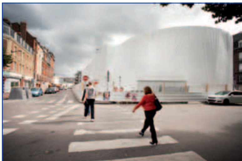
Phase exceptionnelle : confinement total pour désamiantage avant la démolition.
