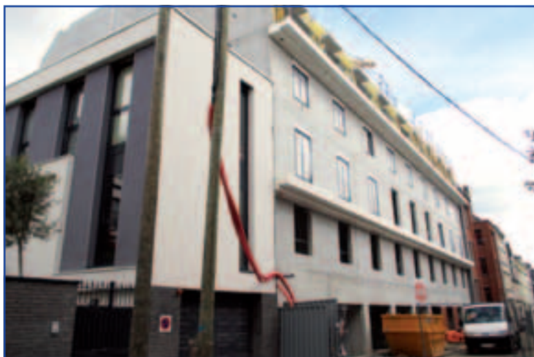
D'ici juin 2015, le nouveau foyer de travailleurs migrants rue du Renard remplacera les foyers El Hadji Omar et Stanislas-Girardin dans un bâtiment écologique.
