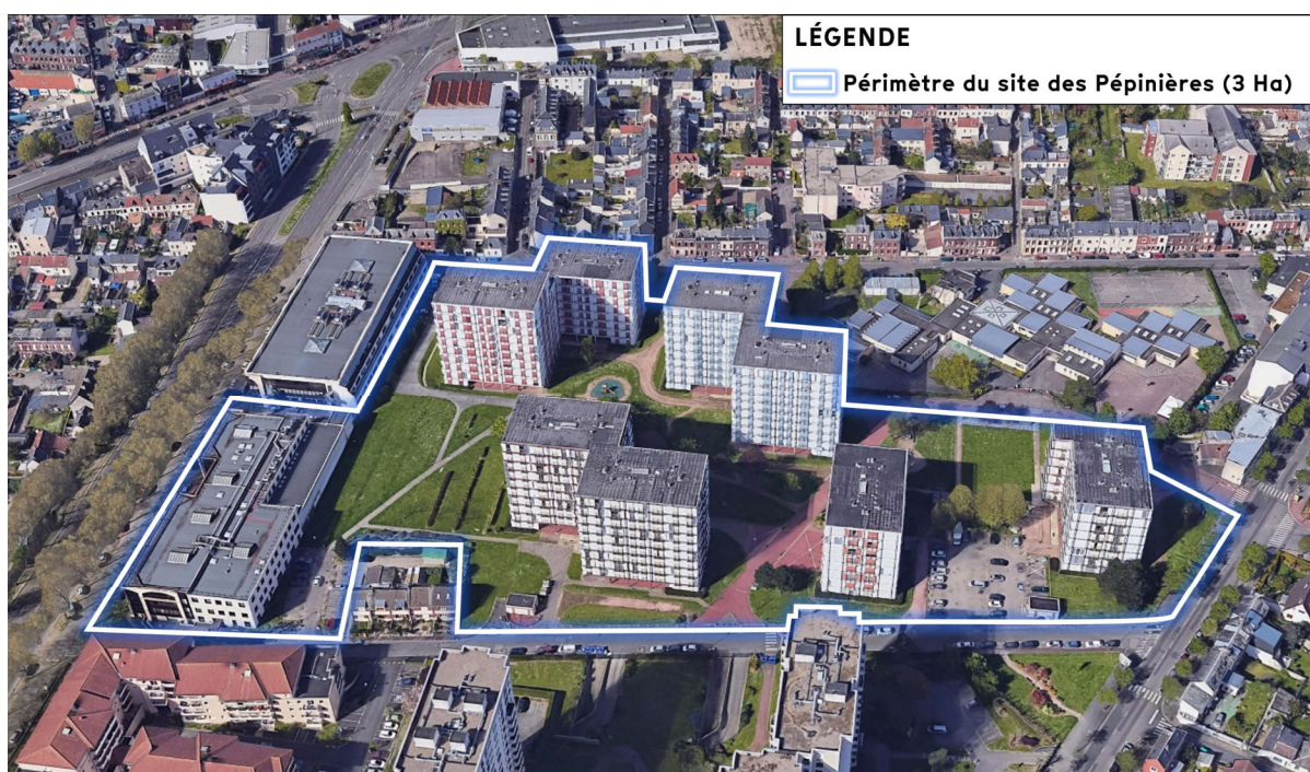
Figure 3. Vue oblique du site des Pépinières
