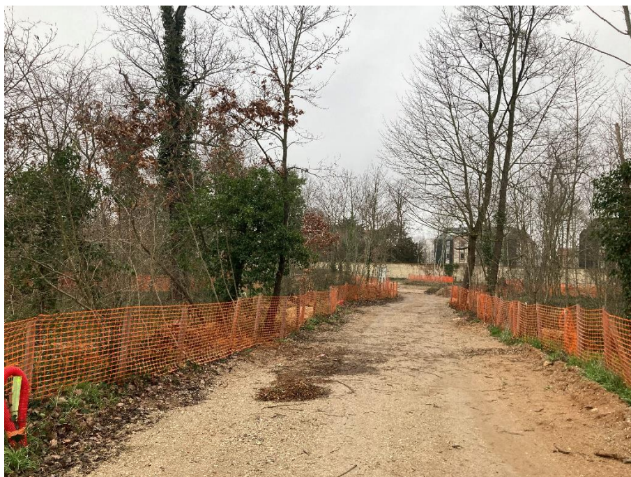
Figure 73 : Balisage de zones arborées à conserver sur un chantier d'Île-de-France © ARP-Astrance 2021
