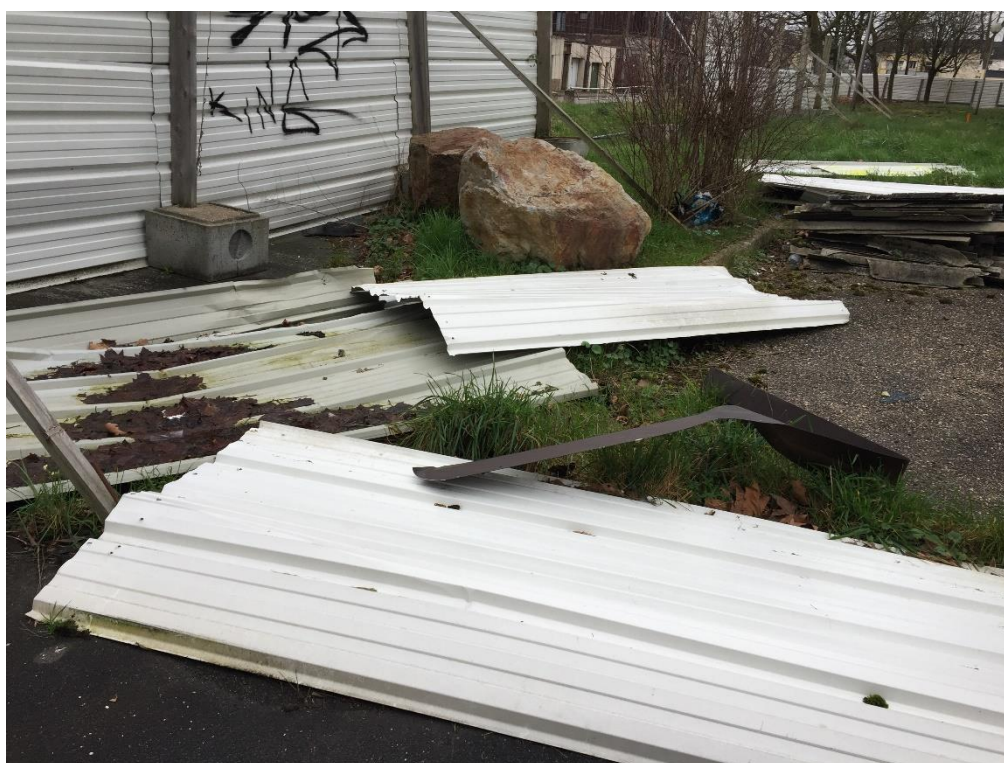
Figure 65 : Tôle ondulée et pierrier sur le sol © ARP-Astrance février 2022
