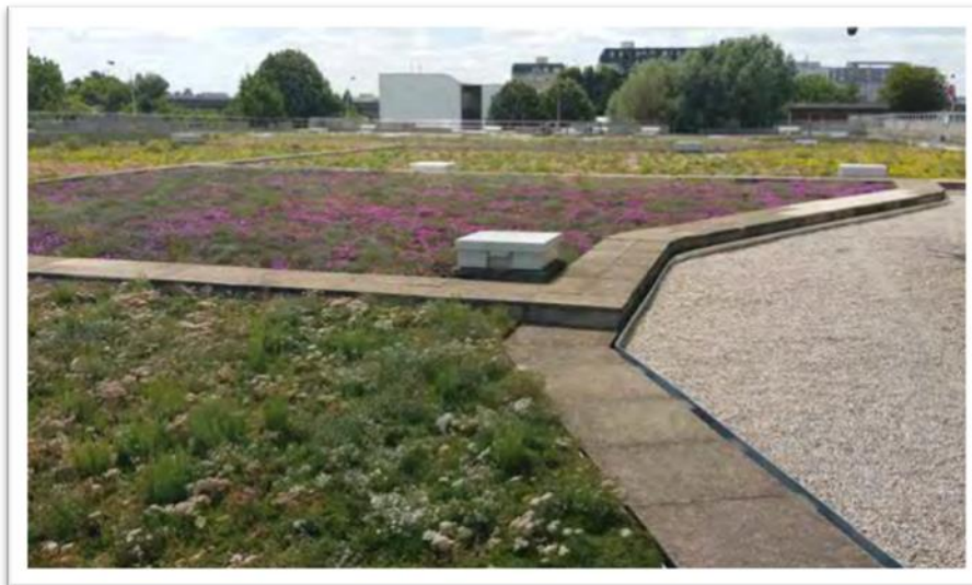
Toiture stockante végétalisée Source : Ecovegetal
