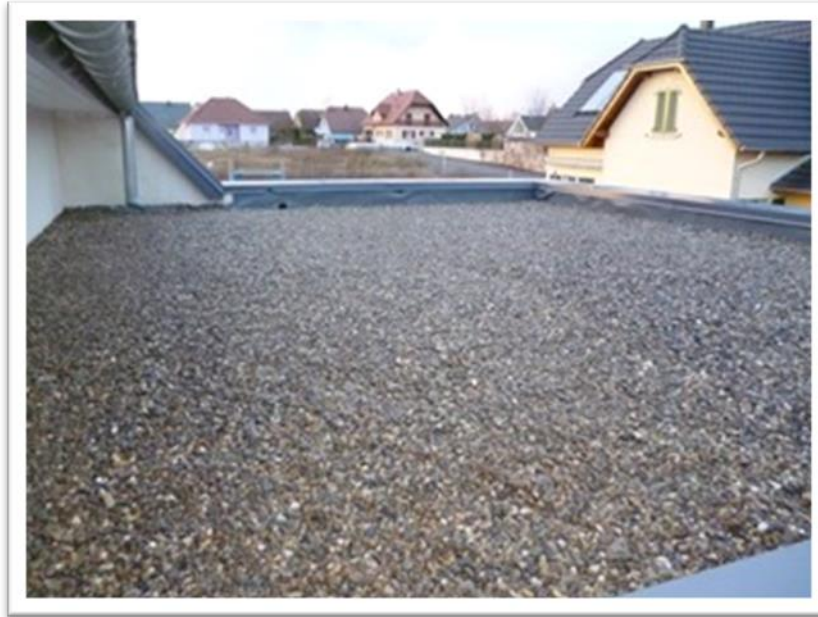
Toiture stockante gravillonnaire Source : Flexirub
