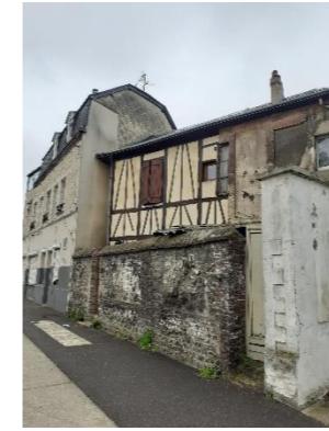
Figure 116 – Maison en colombage – Avenue de la Libération, TERAO 2022
