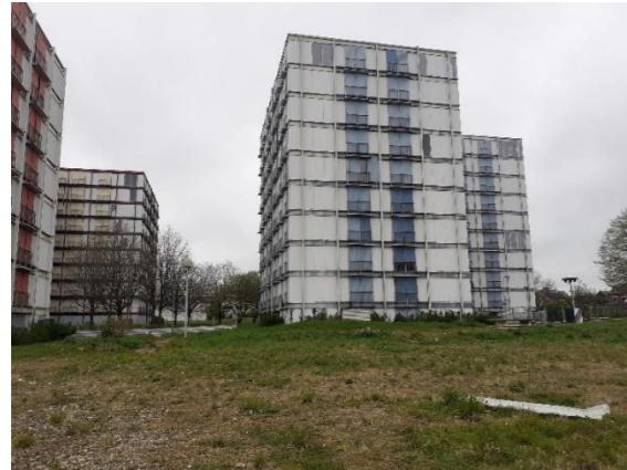
Figure 263 – Remblais suite aux démolitions (Source : TERAO 2022)
