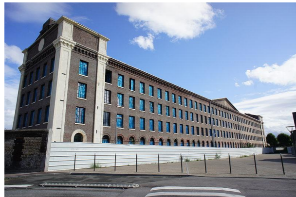
Figure 126 - Ancienne filature La Foudre, puis caserne Tallandier, Monumentum
