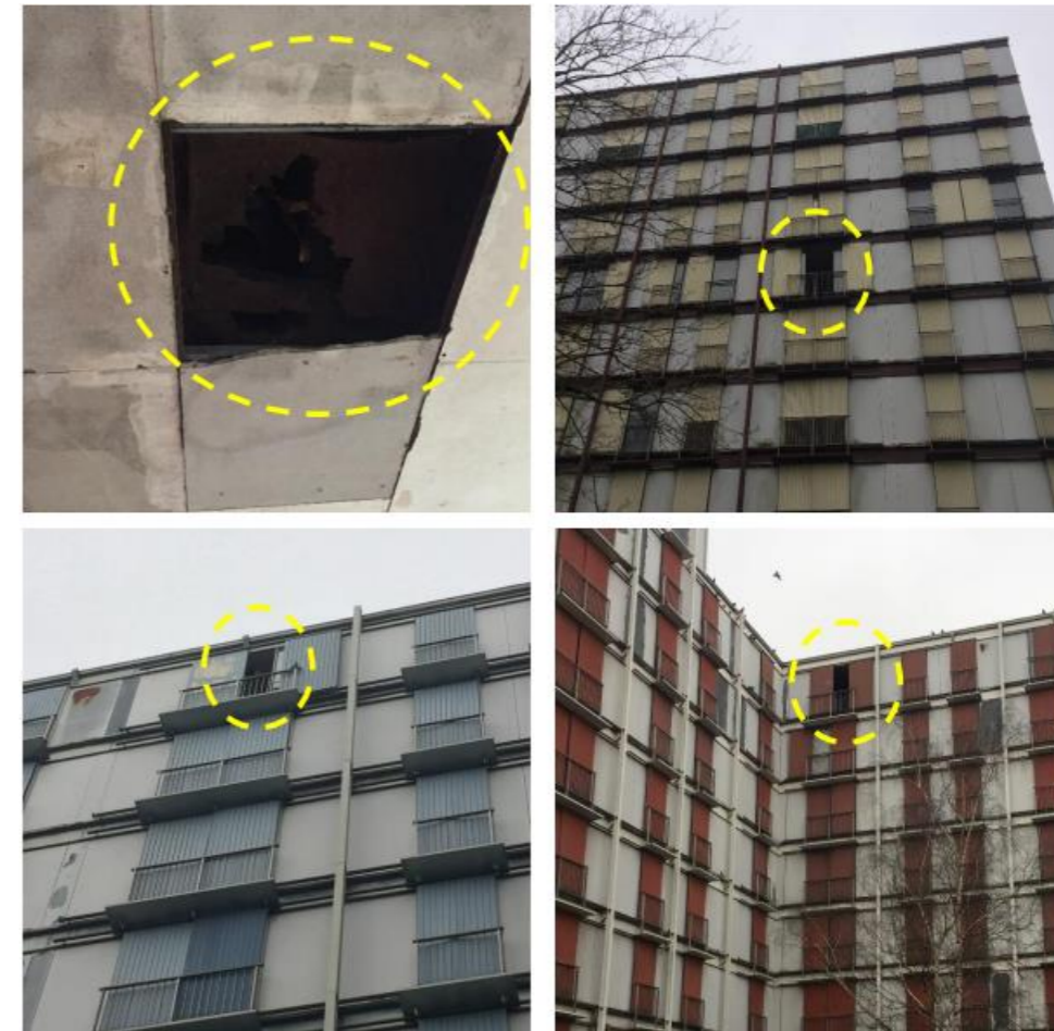
Figure 91 : Photographies d'ouvertures visibles dans le bâtiment du site, ARP-Astrance 2022
