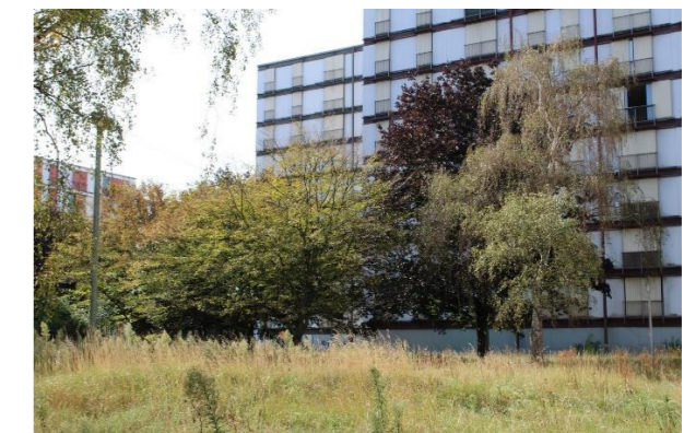
Figure 104 : Photographie 4 – Vue du bosquet d'arbres central, du Nord-Ouest vers le Sud-Est
