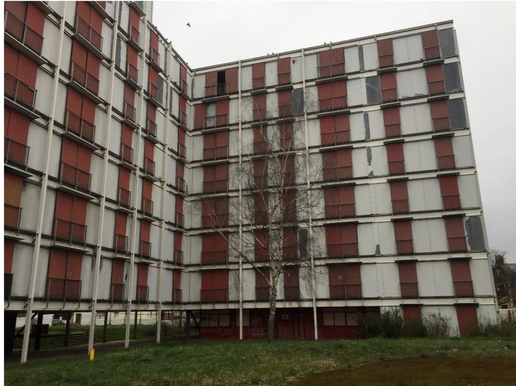
Figure 79 : Bâtiments du site à enjeux modérés (ARP-Astrance, février 2022)
