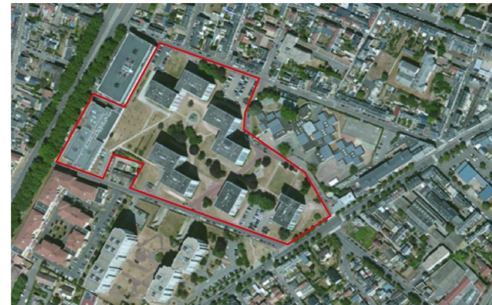
Figure 27 : Image aérienne du site en période estivale, Google Maps
