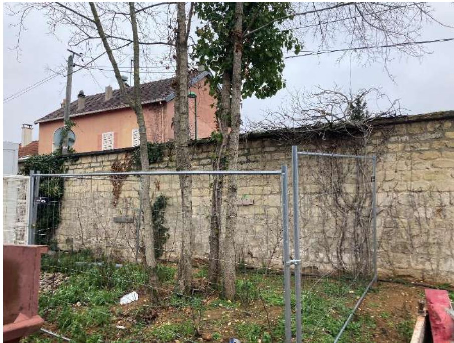
Figure 72 : Balisage d'arbres à conserver sur un chantier d'Île-de-France © ARP-Astrance 2021
