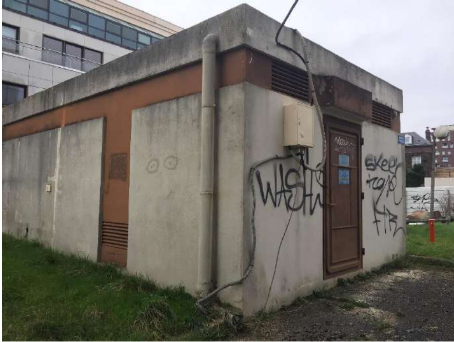
Figure 42 : Bâtiment du site à enjeux nuls © ARP-Astrance février 2022
