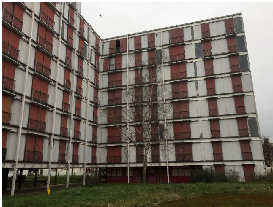
Figure 41 : Bâtiments du site à enjeux modérés © ARP-Astrance février 2022
