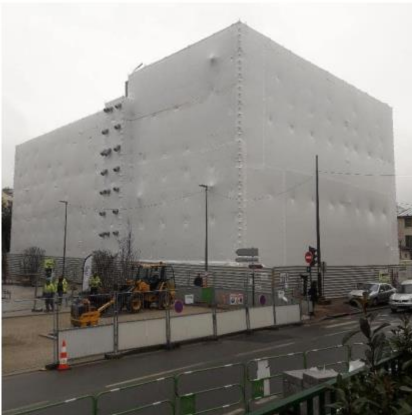
Figure 3 : Bâtiment confiné pour le traitement de l'amiante - Acceo
