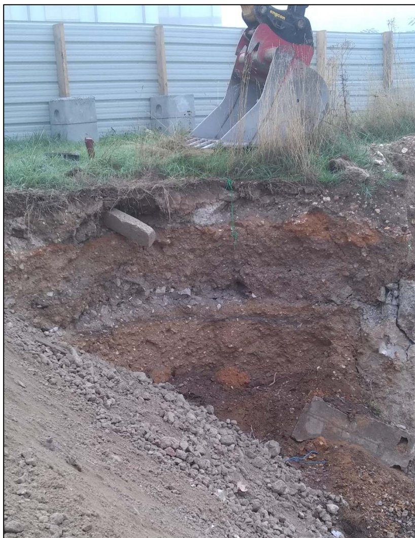
Photo 1 : coupe lithologique au droit d'un chantier en cours en partie ouest du site d'étude
