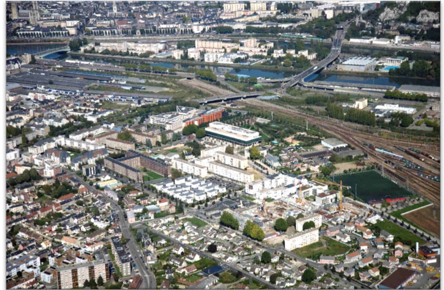
Vue aérienne du quartier Grammont
