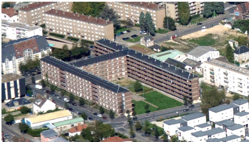
Quartier Grammont – Immeuble Jules Adeline avant sa démolition en 2017
