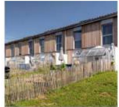
Logements individuels Ateliers-du-Rouget_Limoges
