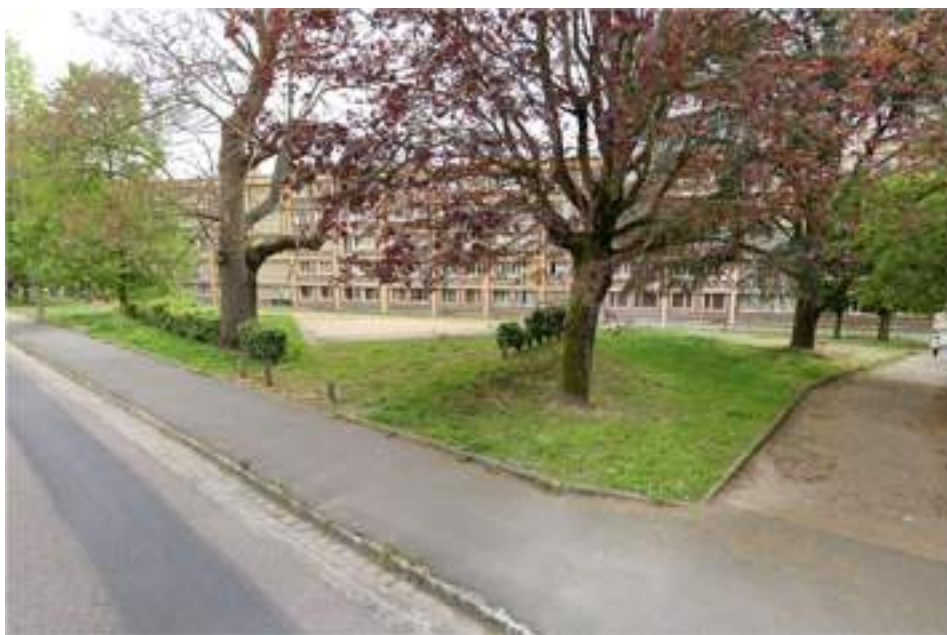
Quartier des Sapins, immeuble Kleber – Vue de l'existant depuis la rue Albert Dupuis
