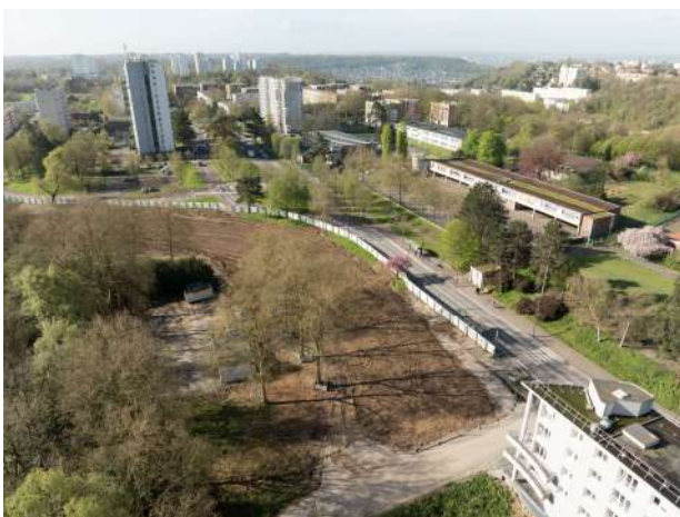
Démolition de la Banane
