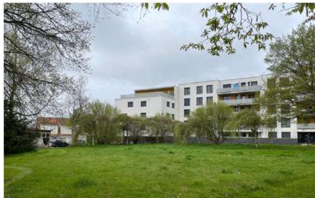
Sauvegarder l’aspect végétal du quartier
