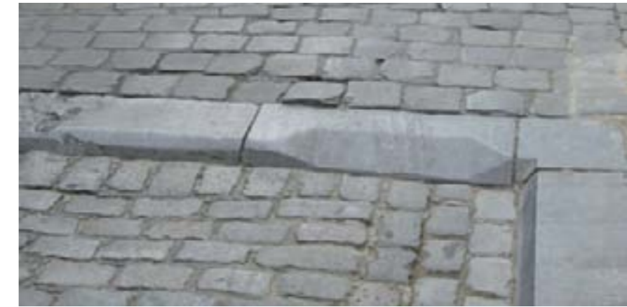
Exemple de chanfrein pour les deux roues
