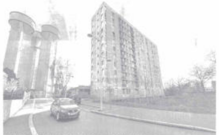
Renouvellement urbain des Hauts de Rouen (Paris 107/108) (10/21)
