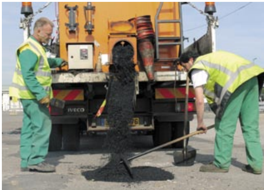
Près de 150 tonnes d'enrobé ont été utilisées pour combler 450 trous sur la voirie.
