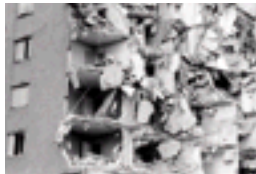
Les démolitions de GBR
