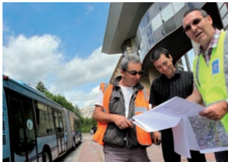
Le chantier d'implantation de la station Mef nécessite 4 mois de travaux sur le tracé Teor.
