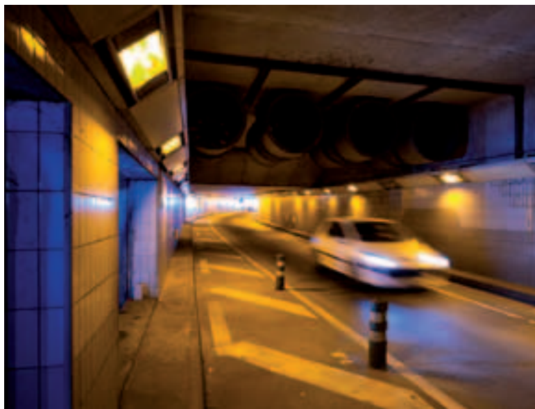
L'ensemble de l'éclairage sera revu et le tunnel entièrement nettoyé pendant la durée du chantier.
