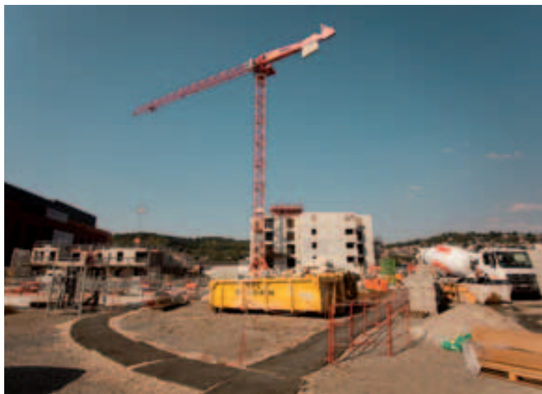
Si la labellisation n'en est encore qu'à l'étape du papier, le chantier, lui, avance à grands pas.
