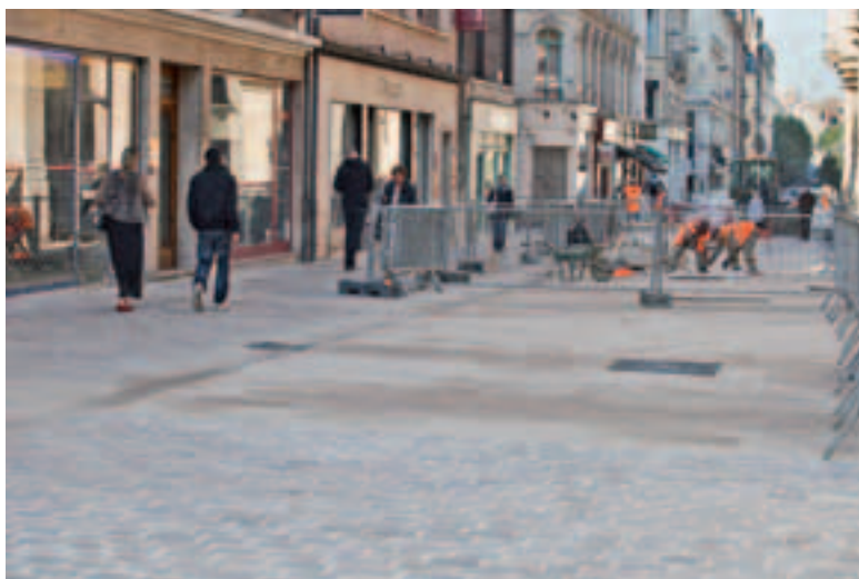
C'est la portion de la rue aux Juifs qui longe le Palais de Justice qui est en passe d'être achevée.
