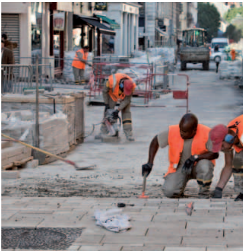
D'ici à la mi-novembre, la première tranche des travaux de la rue aux Juifs sera achevée. La totalité
