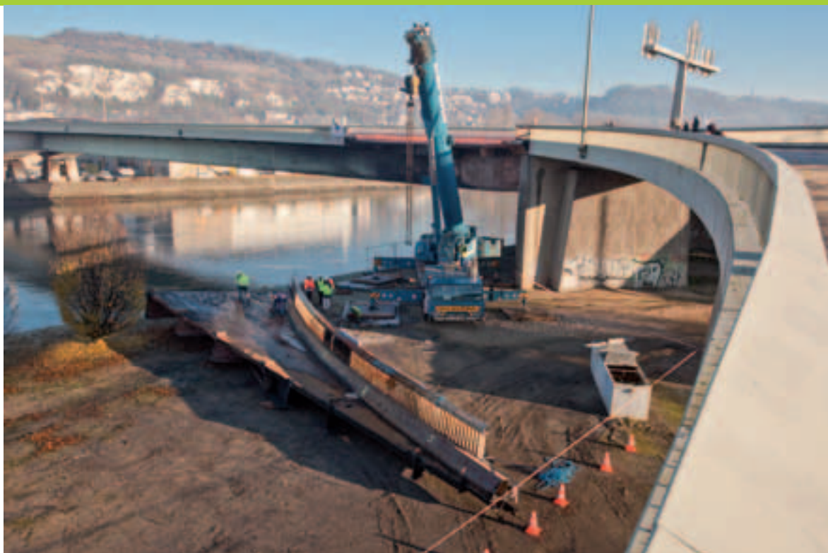
Les travaux de reconstruction du pont Mathilde avancent conformément au calendrier prévisionnel. Après le retrait de l'amorce de la bretelle aval en décembre (ci-dessus), la travée endommagée sera déposée le 22 janvier.
