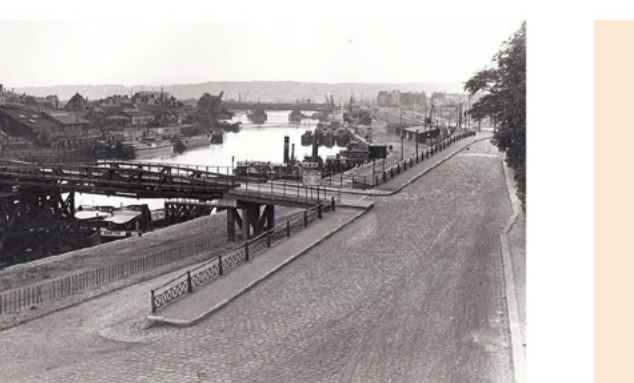
La passerelle vers le Pré aux Loups. (Photo Ruchtel)
