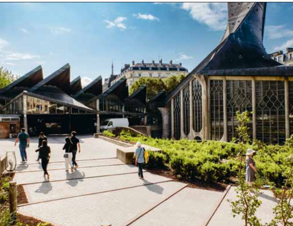
Récemment terminée, la nouvelle place du Vieux-Marché, sur sa partie haute, longe l'arrière de l'église Sainte-Jeanne-d'Arc et mène les passants directement des terrasses aux halles.
