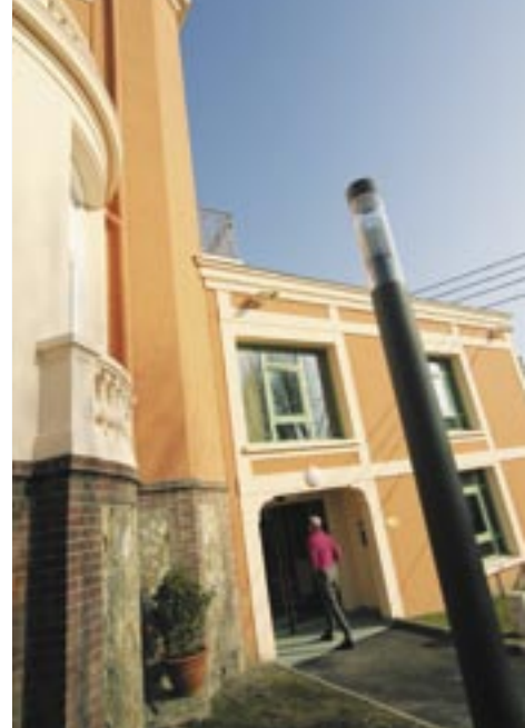
L'implantation du centre de l'ONM permet à l'accueil de l'ex-clinique, en rez-de-chaussée bas, de conserver sa fonction d'origine.
