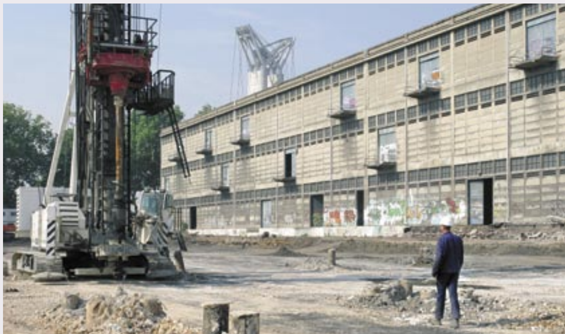
Le chantier a démarré début avril pour une ouverture des Docks prévue d'ici à 2009.
