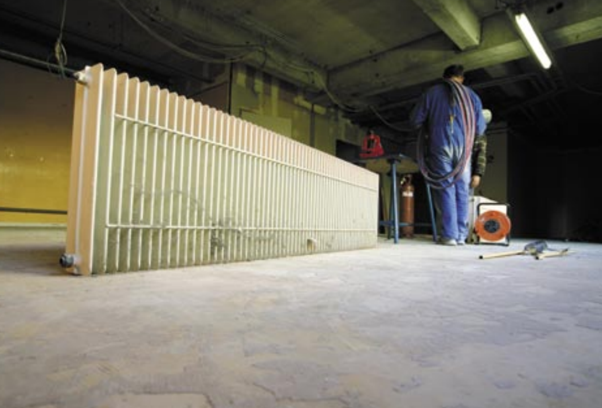
La Ville a entamé l'aménagement et la mise aux normes des anciens locaux du centre médico-social.
