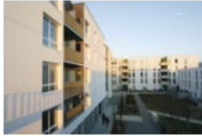
Logement. Chantier terminé à Grammont : le 13 décembre, le bailleur social le Toit Familial livre 81 logements construits à proximité du terrain de football. Une construction originale en deux parties, dont l'une avait été livrée en juin.
