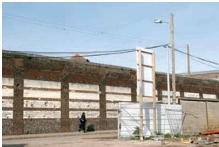
À terme, une caserne de pompiers sera édiflée à l'angle des rues aux Anglais et Dambourney.
