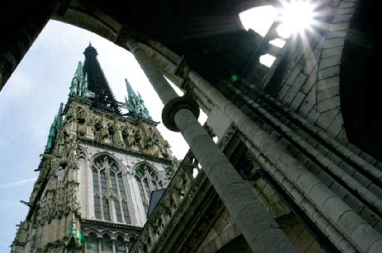
La première tranche de travaux de restauration de la flèche est attendue avant fin 2009.
