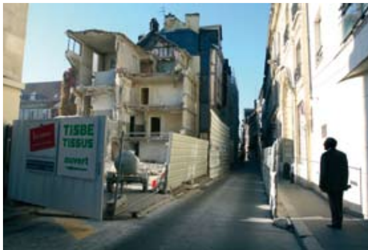
Jusqu'au 28 novembre, le promoteur procède à la déconstruction de la façade.
