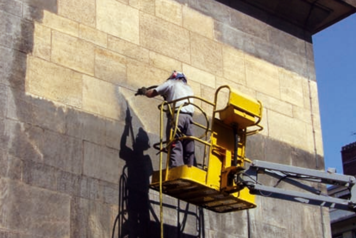
Toutes les façades de la Halle aux Toiles ont eu droit à un décapage par hydrosablage.
