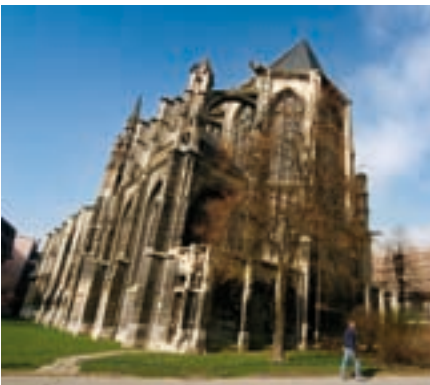
Restauration. Depuis la fin de l'été, le temple Saint-Éloi bénéficie de travaux de restauration et de consolidation pour une réouverture culturelle et culturelle en 2010.
