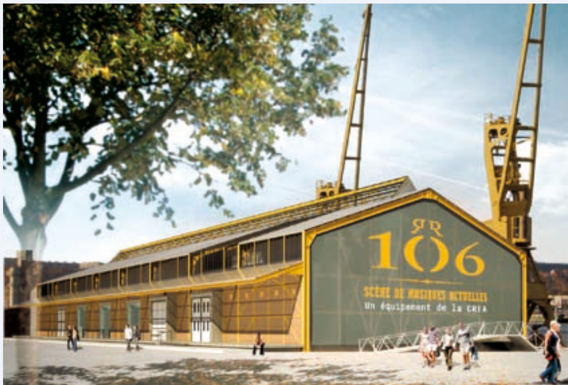
Parmi les projets que la Crea souhaite développer sur Rouen, le 106, hangar des musiques actuelles, ouvrira ses portes à la fin de l'année.
