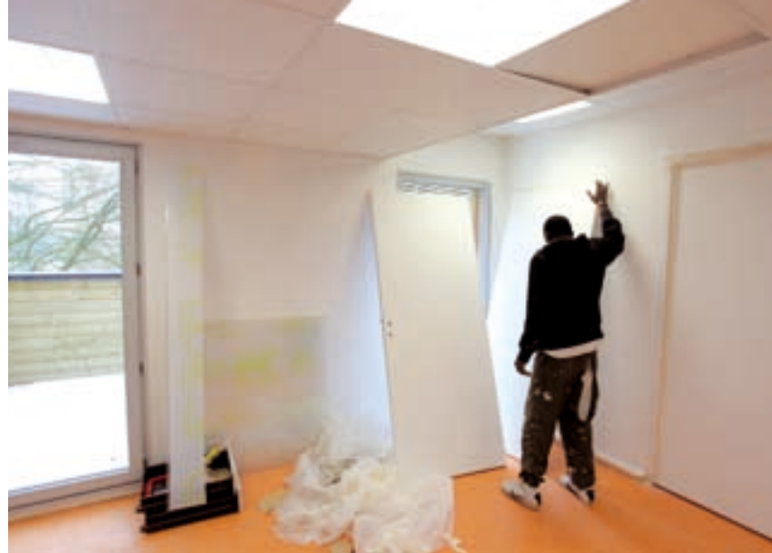
Les locaux de l'association IMS (Insertion Multi service) sont quasiment terminés.
