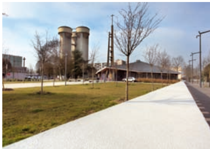
Le permis de construire du CMS du Châtelet a été délivré le 8 mars.
