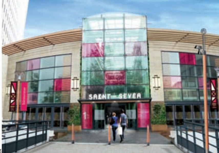
Les travaux de décoration entamés au centre Saint-Sever s'achèveront en février 2011.
