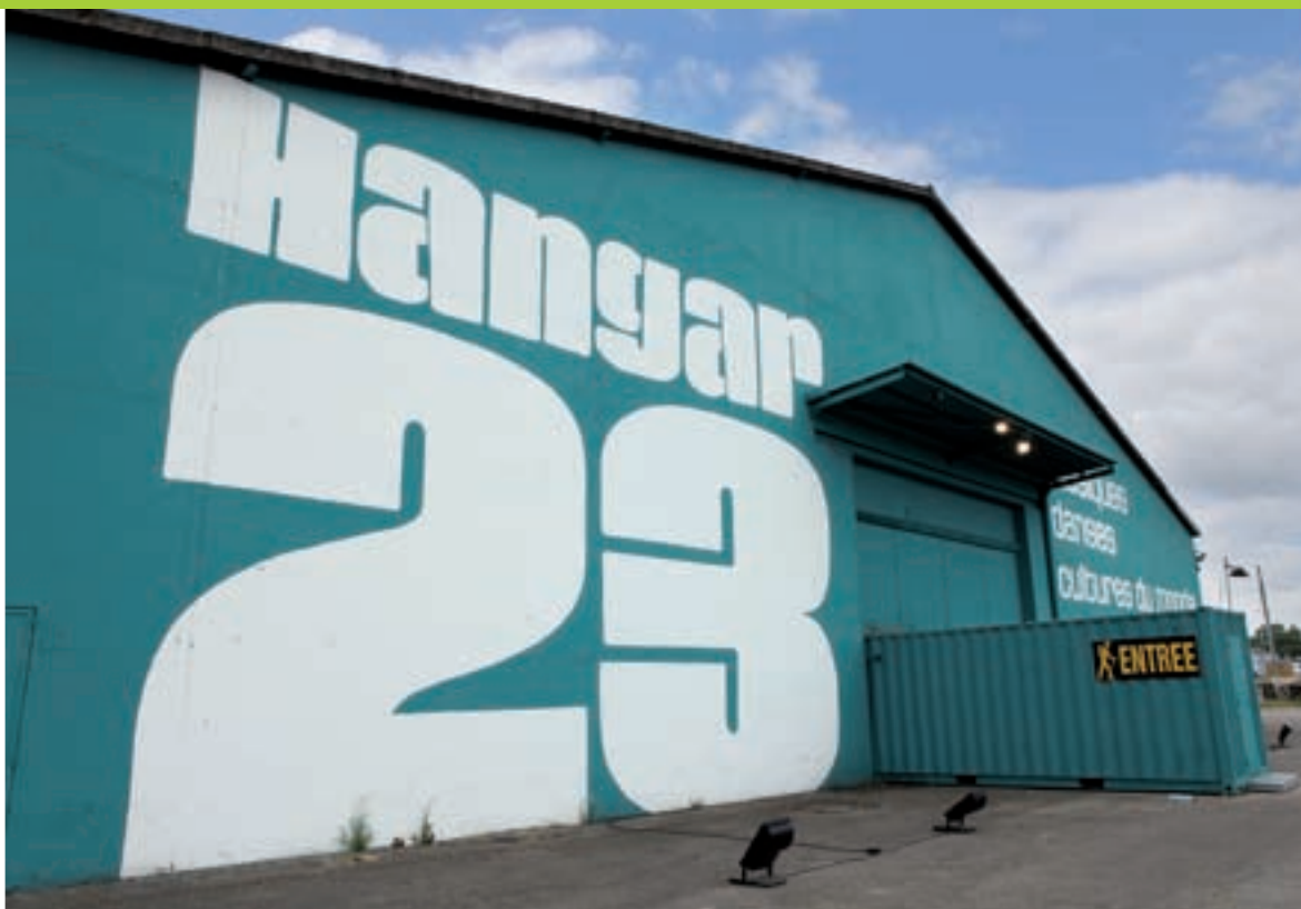
Les 4 000 m 2 de toiture du Hangar 23 vont être rénovés.
