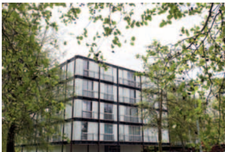
Seuls quatre Verre et Acier seront conservés sur les Hauts de Rouen, après réhabilitation.
