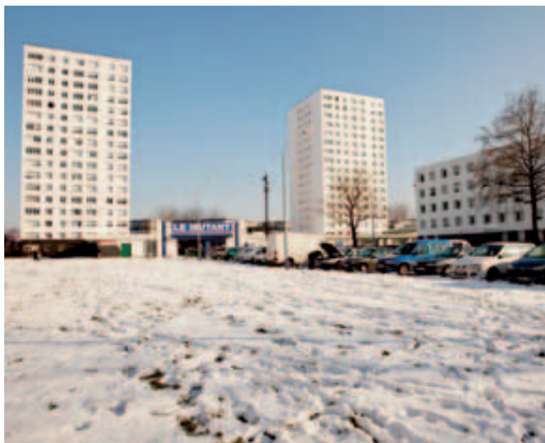
C'est l'ensemble de la place qui sera transformé, marquant ainsi la fin des travaux sur le quartier.
