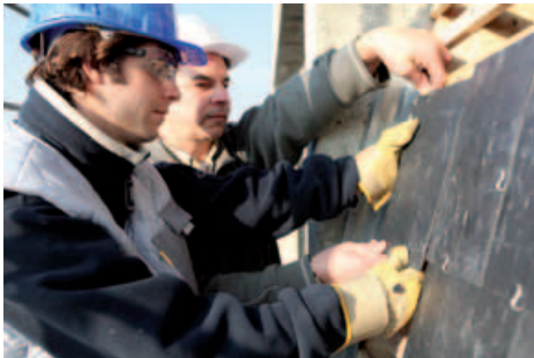
Mardi 23 avril, rendez-vous à la Cité des Métiers pour une rencontre consacrée au bâtiment.
