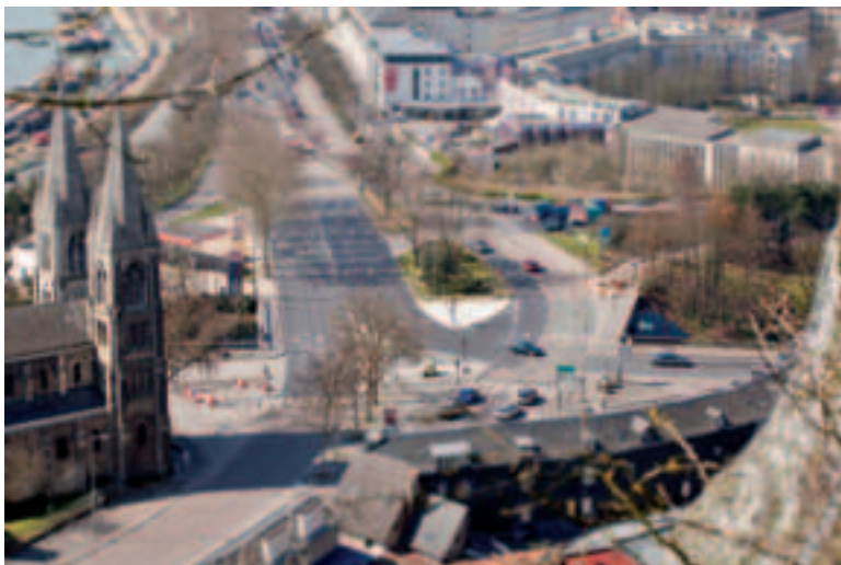
La circulation pourra continuer même pendant les travaux grâce à un aménagement des voies.
