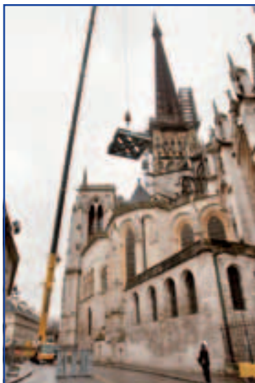
Grutage de l'embase du clocheton Nord-Est rénové.
