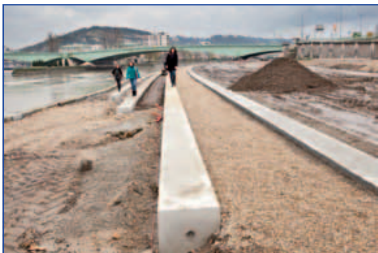
Lors d'une visite de chantier, en février, les escaliers se dessinent peu à peu.
