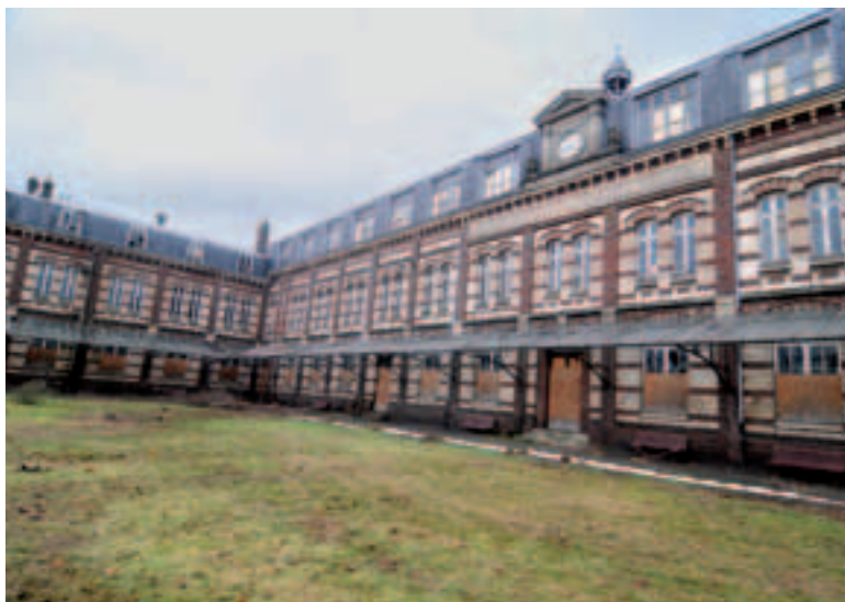
Le bâtiment, ici en 2011, a aujourd'hui été déconstruit. Le projet de Palais intègre par contre certains éléments symboliques de son histoire, à l'image de l'horloge du fronton principal.
