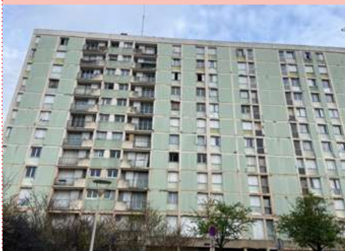
L'immeuble Rousseau au Châtelet
