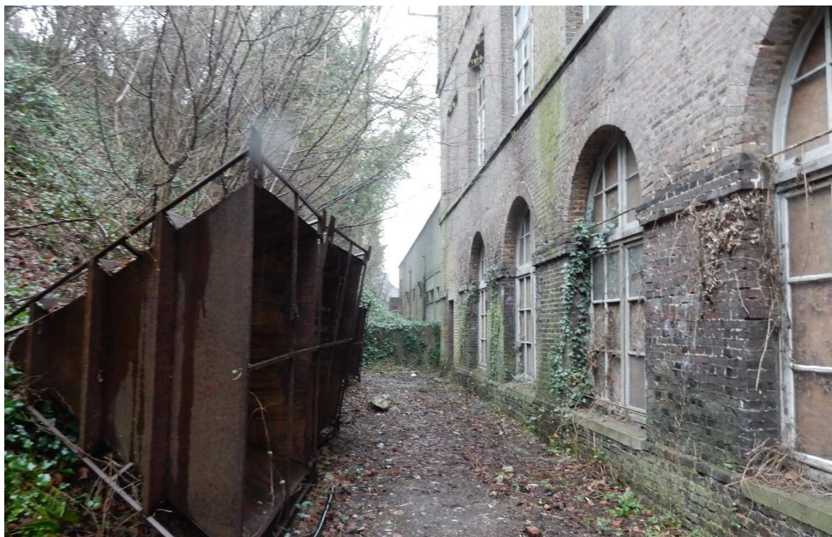
Vue façade arrière et talus (sud)
