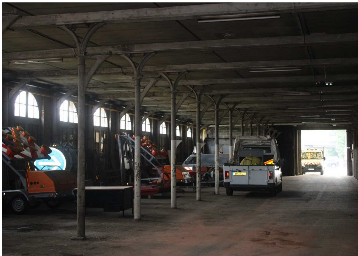
Rez-de-chaussée avec stockage DEPN
