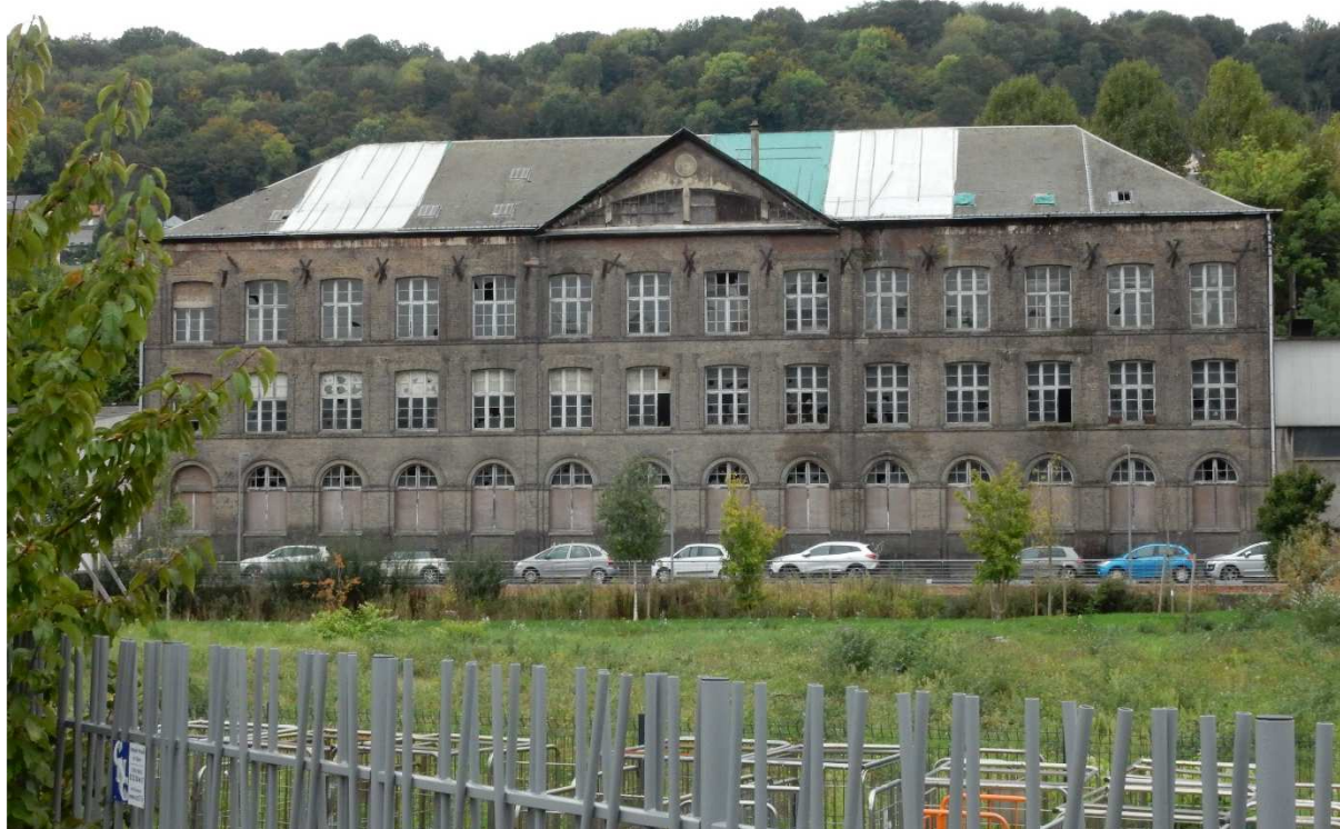
Vue façade principale (nord)
